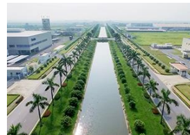
第二タンロン工業団地
