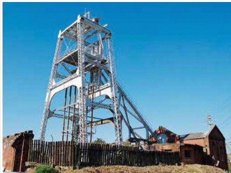
宮原坑 日本の産業化を支えた炭鉱遺構 【所在地】福岡県大牟田市宮原町1丁目86-3 【連絡先】0944-41-2515 (大牟田市世界遺産・文化財室)
