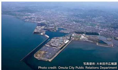
三池港 今も現地で稼働する三池炭の積出港 【所在地】福岡県大牟田市新港町 【連絡先】0944-41-2515 (大牟田市世界遺産・文化財室)
