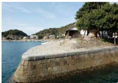
三角西港 三池炭鉱の石炭の積み出しが行われた 【所在地】熊本県宇城市三角町三角浦 【連絡先】0964-32-1111 (宇城市文化振興課)
