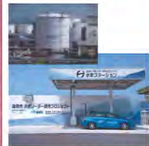
水素リーダー都市プロジェクト（福岡市：下水汚泥消化ガス）
