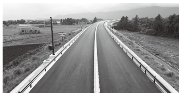
東九州道(大崎~鹿屋)田原迫ノ上地区舗装工事
