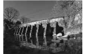
造形も見事な石造10連アーチの旧郡築新地甲号樋門 (八代市提供)
